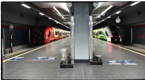
fot. Michał Jagusiak Warszawa Lotnisko Chopina - Podziemna czołowa stacja kolejowa
